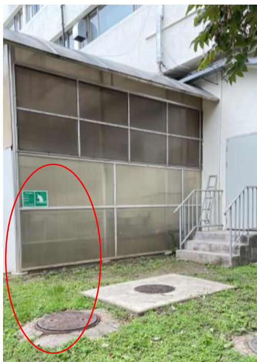
废水总排口及标识牌
